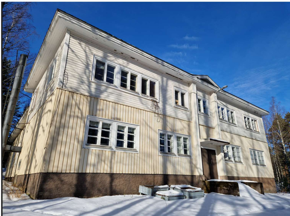
Kuva 1 Vartiolinna, julkisivu itään
