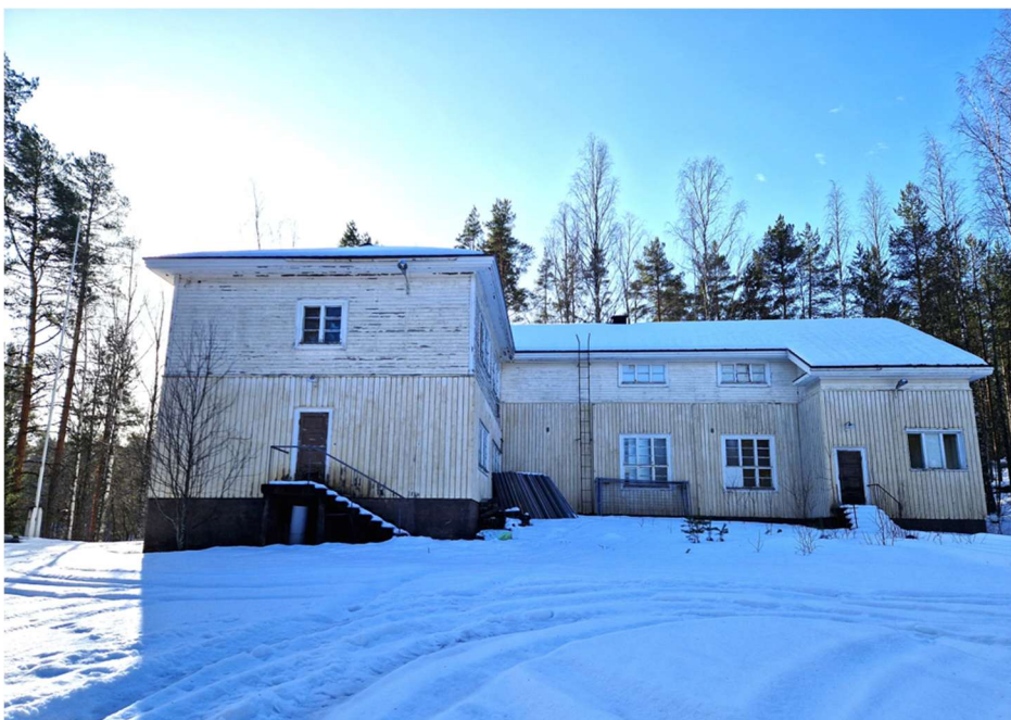
Kuva 2 Vartiolinna, julkisivu pohjoiseen
